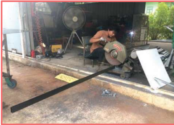
รูปที่ 2-6 การเตรียมเหล็กโครงด้านข้างหรือเหล็กแป
