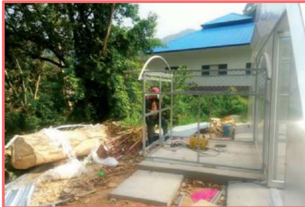
รูปที่ 2-18 การติดตั้งโรงเก็บเบิร์นเนอร์ของระบบบ่อแห้ง
