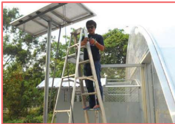
รูปที่ 2-19 การติดตั้งเสาโซลาร์เซลล์และต่อไฟฟ้าเข้าพัดลม DC 12 V
