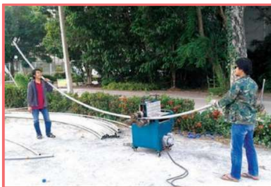
รูปที่ 2-4 การดัดโค้งเหล็กโครงหลังคา
