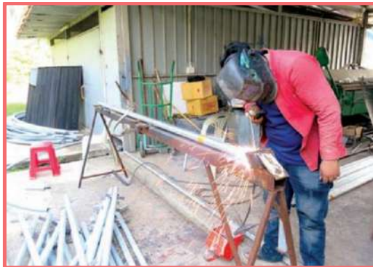
รูปที่ 2-5 การเตรียมเสาเหล็กโครงหลังคา
