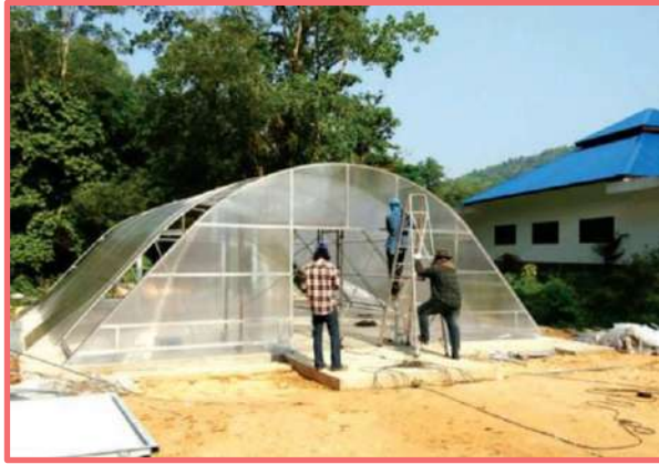
รูปที่ 2-17 การติดตั้งแผ่นโพลีคาร์บอเนตของระบบบ่อแห้ง
