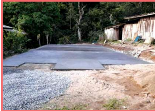
รูปที่ 2-3 พื้นที่คอนกรีตที่เสร็จสมบูรณ์
