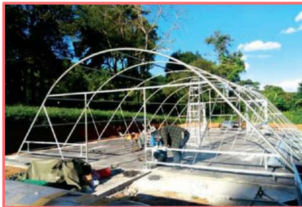
รูปที่ 2-14 การประกอบโครงเหล็กของระบบบ่อบำบัด
