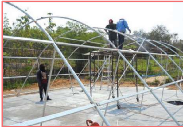
รูปที่ 2-15 การเชื่อมโครงเหล็กของระบบบ่อแห้ง
