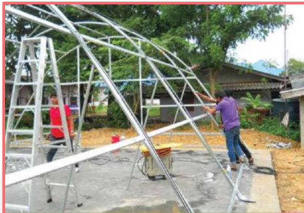
รูปที่ 2-16 การติดตั้งชุด Aluminium Clamping บนโครงเหล็กของระบบบ่อแห้ง
